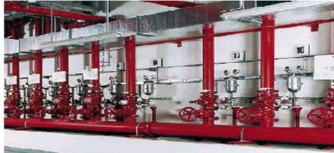
**Stationsverteiler / Alarmventile**
